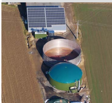
Instalación de biogas
